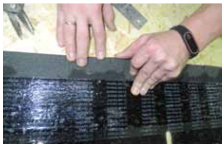
Рис. 6. Насечка для облегчения монтажа
